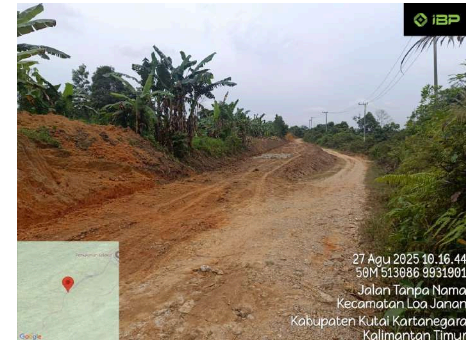
Sesudah proyek pengalihan jalan sementara akibat longsor RT 13 selesai.
